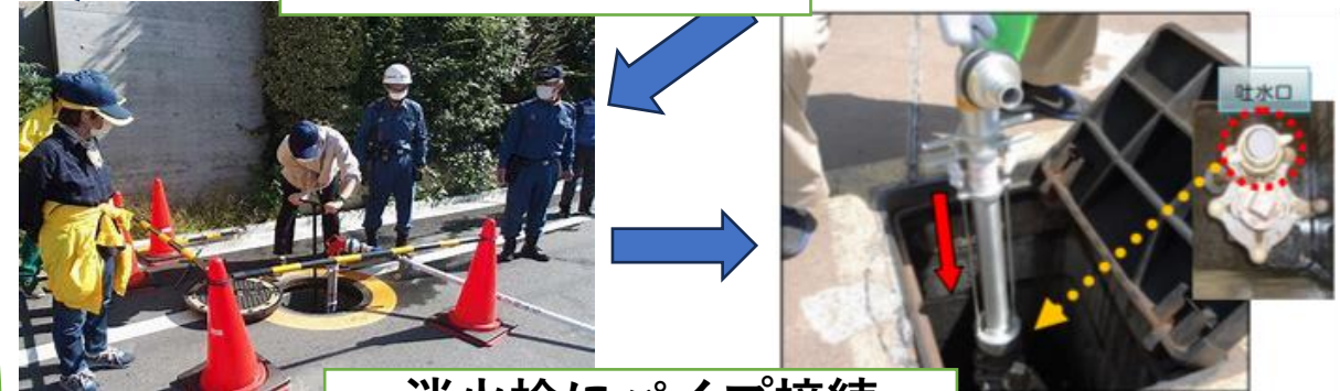
消火栓にパイプ接続
