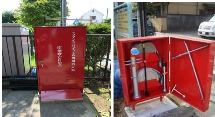
会館横スタンドパイプ収納庫
