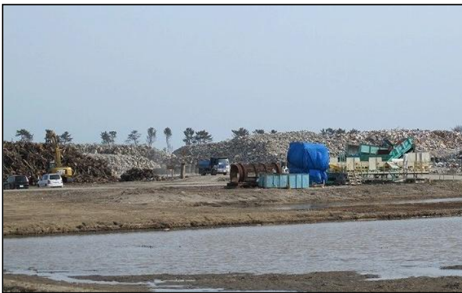
名取市の地盤沈下とガレキ
