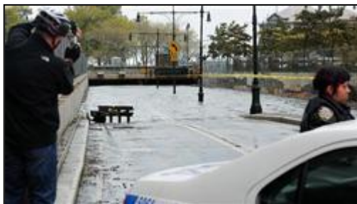
天井近くまで浸水したままのトンネル
