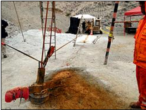
地下に閉じ込められた作業員に物資を補給するための細いチューブ（2本のうちの1本）
