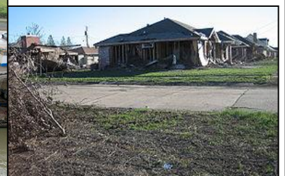
カトリーナで破壊された家
