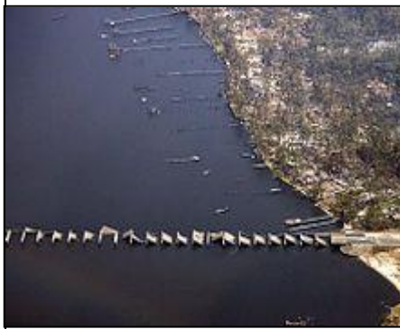
崩落した橋(2005 年 8 月 31 日撮影)
