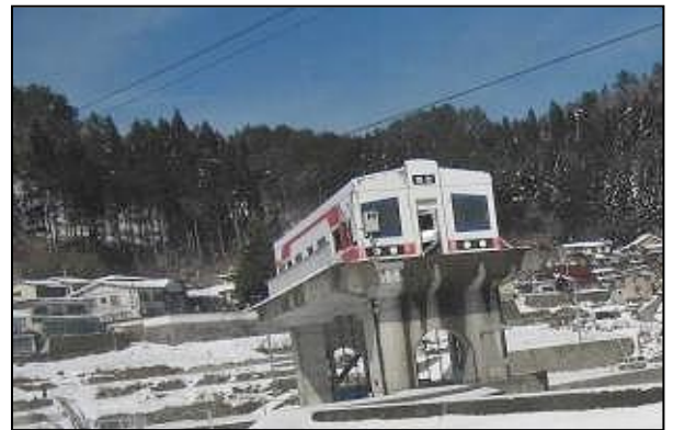
破壊された三陸鉄道の駅舎
