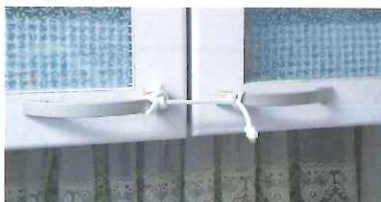
観音開きの扉の固定には、防災グッズの金具でもよいですが、ナイロンロープが汎用性もあり安く購入できて便利です。
