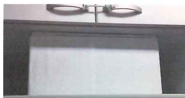
冷蔵庫や食器棚の固定は、天井との間に段ボール箱を入れることで対応可。板などで隙間がでないようにします。
