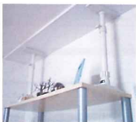
突っ張り棒が天井を突き抜けてしまうことがあるので、板を1枚入れることで強度が増します。
