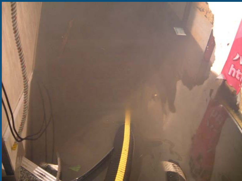
店舗入口まで浸水した状況
