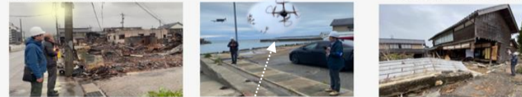
輪島朝市の大規模火災跡 現地をドローン空撮調査 沿岸の村を襲った津波跡
