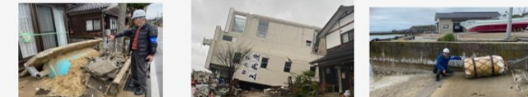
液状化で浮き上がったタンク 地下で柱が折れて倒れたビル 地殻変動で隆起した港
