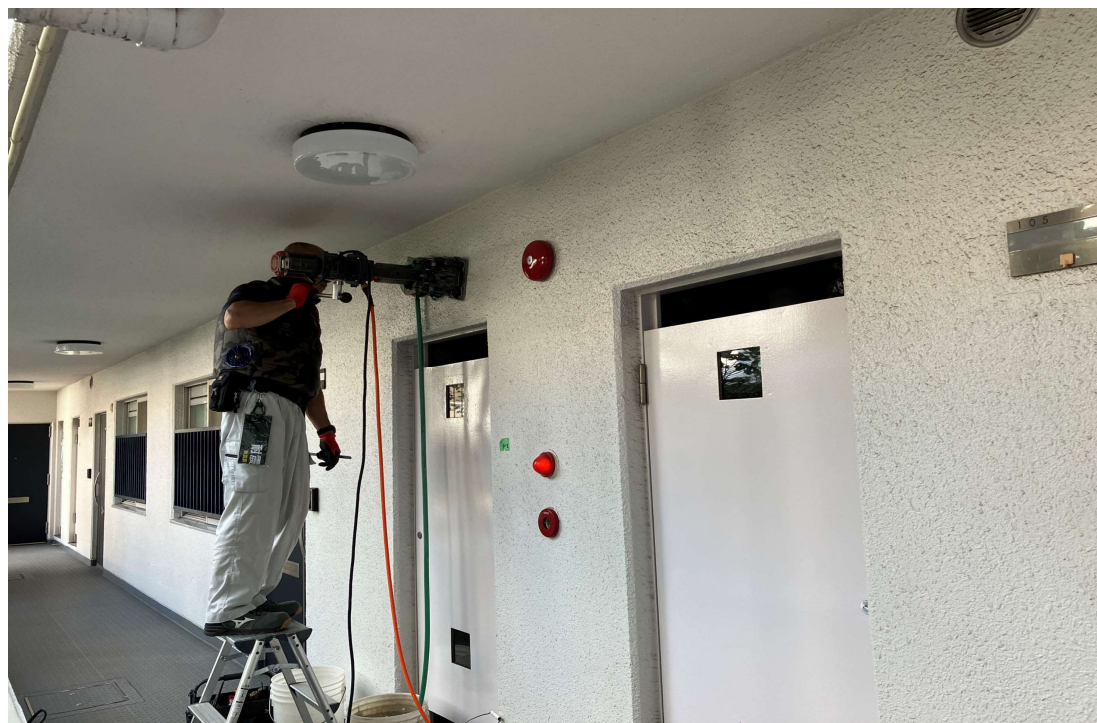
ダイヤモンドカッターでコンクリートサンプル採取
