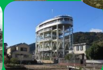
高知県黒潮町・津波避難タワー
