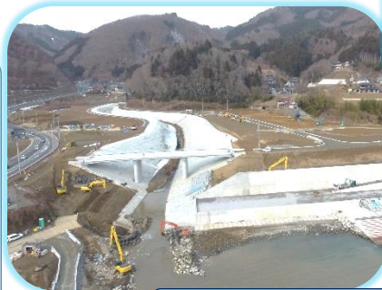
宮城県気仙沼市唐桑町只越地区の護岸橋の復旧堤の様子
