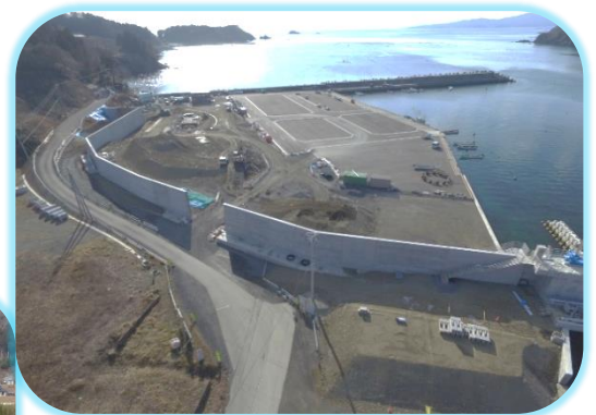
宮城県南三陸町管の浜地区に 建設中の防潮堤の様子
