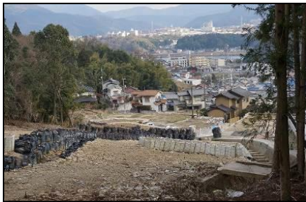
広島市八木地区の土砂災害現場
