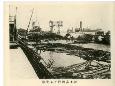
崩壊した栈橋及上屋
