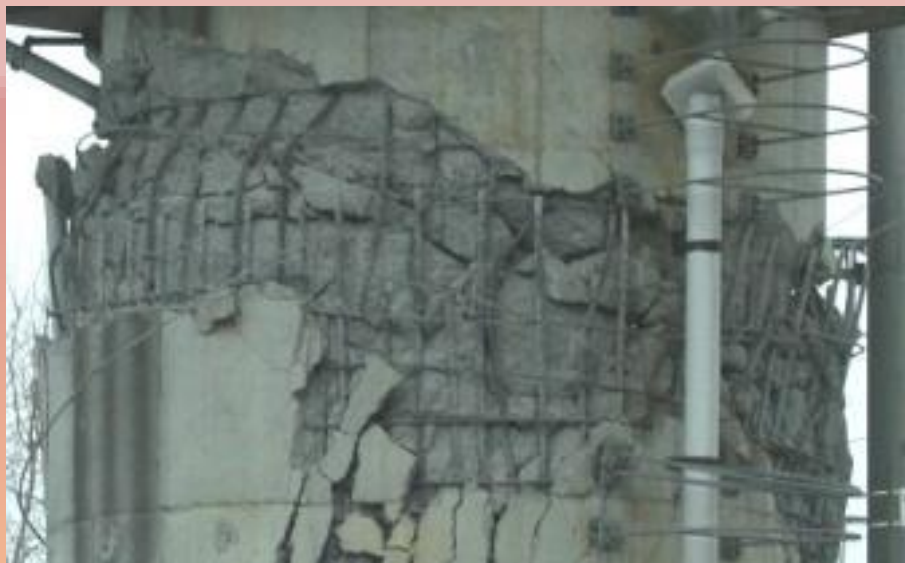
震度7に耐えた高架橋
