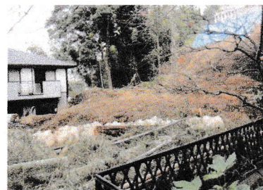
左端の建物1階に土砂侵入
