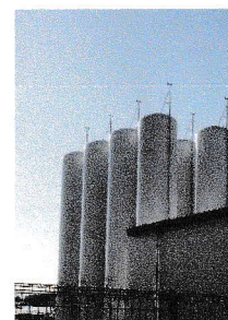
図11：水素を貯蔵する18mのタンク
