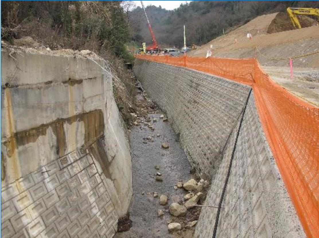
堰堤に溜まった土砂を排除して、新しい土手を固めて道路の建設を進めている
