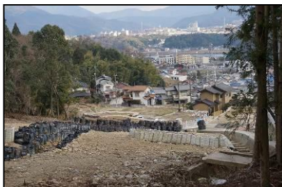
広島市八木地区の土砂災害現場
