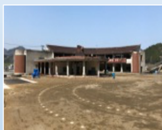
大川小学校震災遺構
