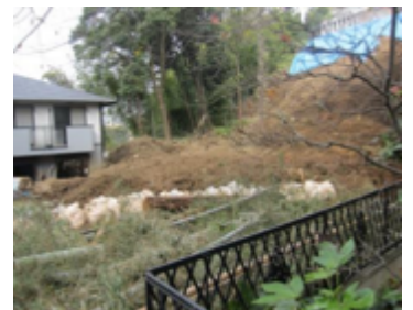
左端の建物1階に土砂侵入
