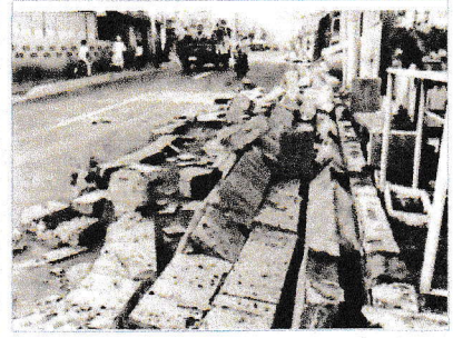
1978年宮城県沖地震(M7.4)における仙台市内の建物被害と多発したブロック塀・石塀の被害
